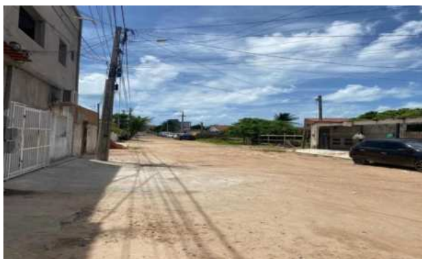
Figura 1.1-5. Edificações residenciais na área de estudo sem pavimentação e drenagem.
